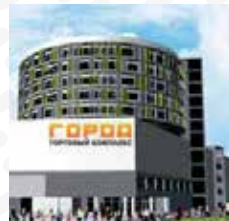
Торговый центр «Город», г. Москва, Рязанский проспект, 2
