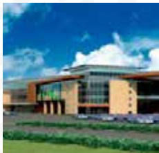
Торговый центр «Сити-Молл», г. Белгород, ул. Щорса, 64
